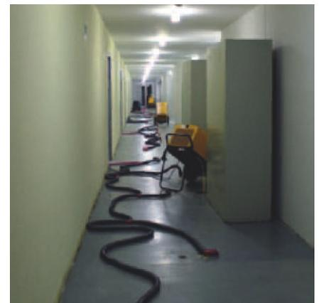
Die Kombination von Hohlboden in der Turnhalle und 1.000 m<sup>2</sup> Estrich mit 5 cm EPS als Dämmung in den angrenzenden Sanitär- und Technikräumen bedeutete für Planer und Sanierer eine besondere Herausforderung.
