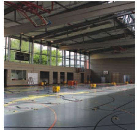
Nach erfolgter Feinreinigung und technischer Trocknung wurde über Materialproben und Luftkeimmessungen der Erfolg der Sanierung überprüft.
