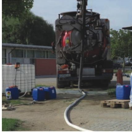
Zum Anmischen der Wirkstofflösung wurde Leitungswasser direkt aus dem Hydranten entnommen. Die beiden Tankwagen wurden im Wechsel befüllt und abgepumpt.
