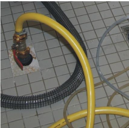
Einbringen der Desinfektionslösung im Bereich der Technik- und Sanitäräume.
