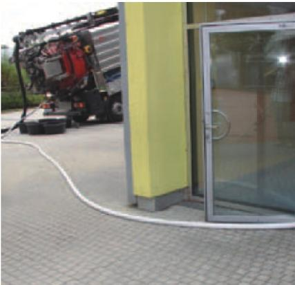
Über den im Tankwagen erzeugten Druck wurde die Desinfektionslösung über einen Schlauch ...
