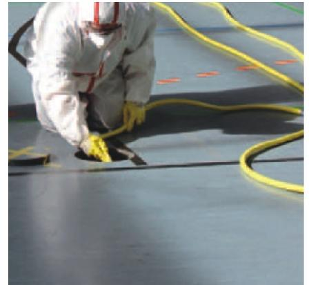
Diese ermöglichte das gleichzeitige Einbringen der Desinfektionslösung über 4 Schläuche in den Schwingboden und den Bodenaufbau der angrenzenden Sanitär- und Technikräume.
