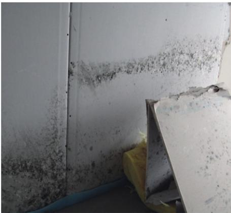
Rückzubauendes, kontaminiertes Material (z. B. verschimmelte Gipskartonplatten) kann vor Ausbau mit JATI Protect eingesprüht und damit eine Freisetzung der Sporen in die Raumluft verhindert werden.
