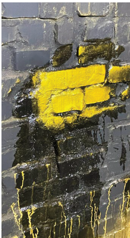
2 | Durchführen einer Testreinigung
