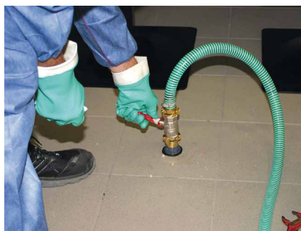
Abb. 5: Bei nicht unterkellerten Bodenplatten ist eine biozide Spülung unter hygienischen und wirtschaftlichen Aspekten die erste Wahl.
