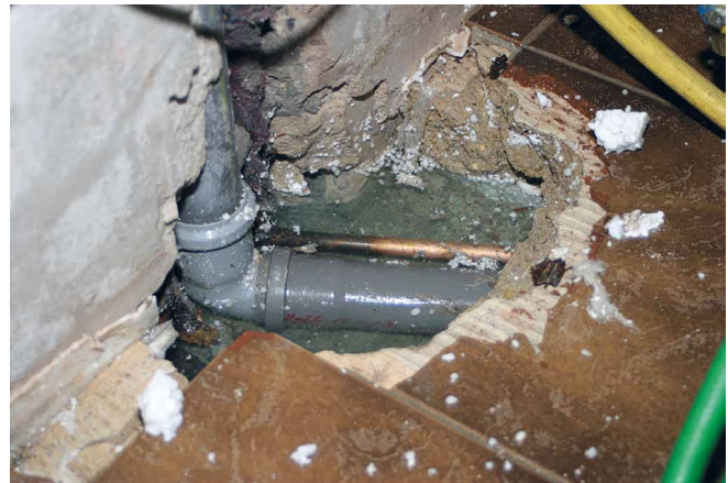
Abb. 9: Durch richtig gewählte biozide Wirkstoffe werden im Boden verbaute Metalle und Kunststoffe nicht geschädigt.
