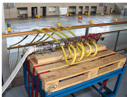
Abb. 2: Auch Großobjekte können nach umfassender Planung und fachgerechter Ausführung erfolgreich ohne umfangreichen Rückbau saniert werden. Im Bild eine Sporthalle mit 2.200 m 2 Grundfläche.
