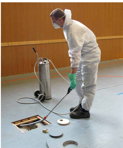
Abb. 1: Schaumbehandlung einer Sporthalle mit 450 m 2 Fläche und einem 9 cm hohen Hohlraum nach einem Wasserschaden
