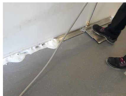
Abb. 6: Alternativ können belastete Randfugen mit biozidem Schaum und einer Randfugenschaumleiste behandelt werden.
