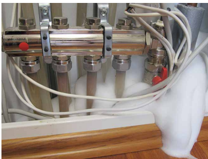
Abb. 11: Auch für Hohlräume wie z. B. Schächte ist die Anwendung von biozidem Schaum geeignet.
