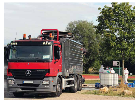
Abb. 3: Das Einbringen der bioziden Spülung (69.000 Liter) erfolgte im Fall der Sporthalle mit zwei Tankwagen mit je 20.000 Liter Fassungsvermögen innerhalb von vier Stunden.
