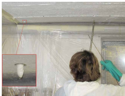
Abb. 12: Biozider Schaum kann auch von unten über Bohrraster durch die Betondecke in die Estrichdämmung eingebracht werden.
