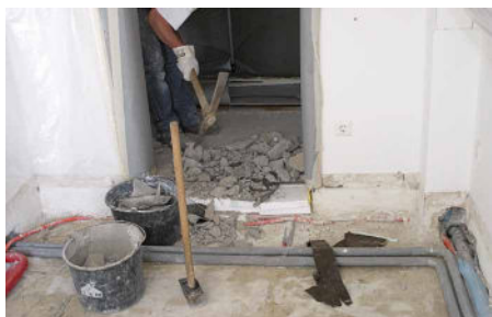
Rückbau von Estrich ist oft nicht erforderlich
